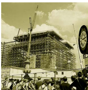
Plac budowy kościoła Frauenkirche
